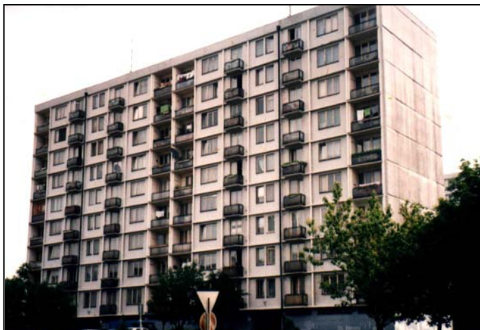
obr. 4.3.1 Pohľad na radový dom LB (Bratislava- Ružinov)
