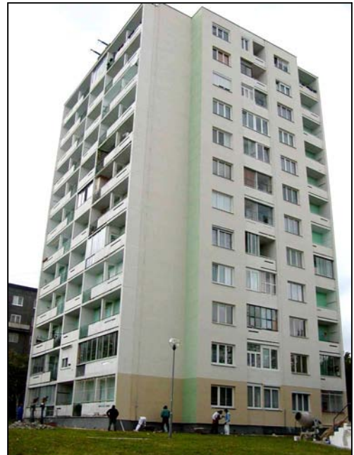
Obr. 4.1.2 Pohľad na vežový dom BA (Račianska 95 – zateplený dom)
