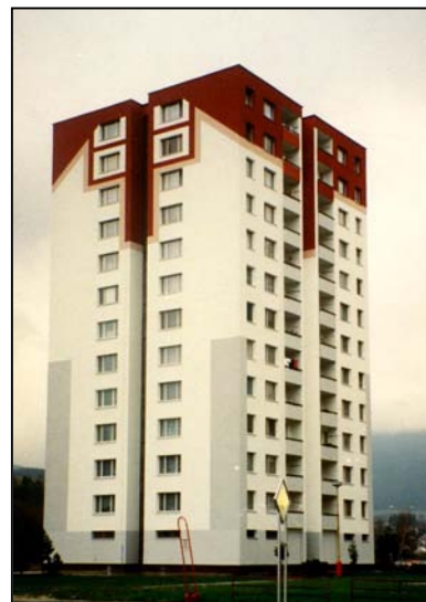
Obr. 4.16.2 Bodový dom P1.14 - 6. 5RP po zateplení ( Kysucké Nové Mesto)
