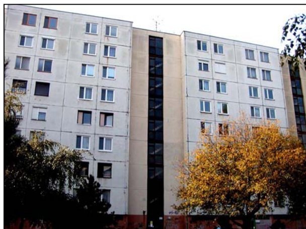
Obr. 4.14.1 Radový dom B-70 (Bratislava, Dopravná ul.)
