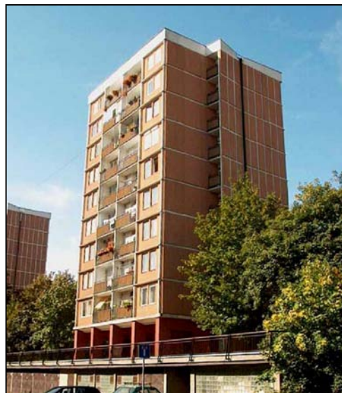
obr. 4.3.2 Pohľad na bodový dom LB (Bratislava J.C.Hronského)
